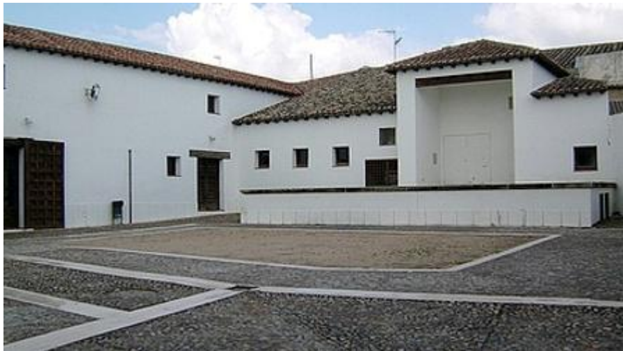
Patio interior de la casa de Cervantes en Esquivias (Toledo)
